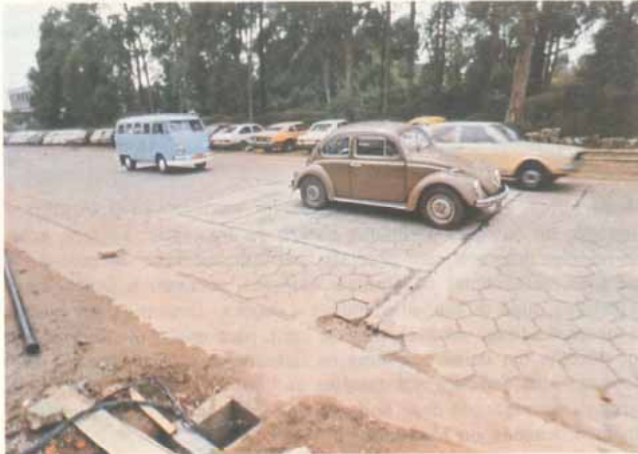
FIG. 13 DETECTOR DE LAÇO INDUTIVO INSTALADO NA VIA
